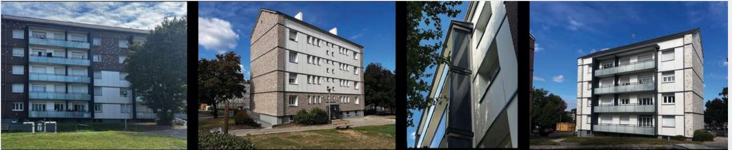
Réhabilitation Multisites Seine-Maritime, Résidence Le Carabachet, Grand-Couronne (76) / Maître d'Ouvrage : HABITAT 76 CHANTIER EN COURS
