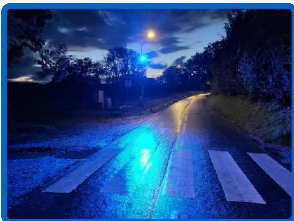
Nouvel éclairage bleu installé sur les passages piétons de la route de Montivilliers (RD311). Un dispositif moderne pour améliorer la visibilité et renforcer la sécurité des piétons.
