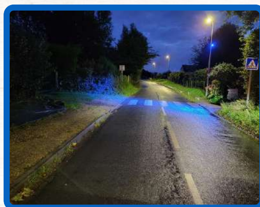
Nouvel éclairage bleu installé sur les passages piétons de la route de Montivilliers (RD311). Un dispositif moderne pour améliorer la visibilité et renforcer la sécurité des piétons.
