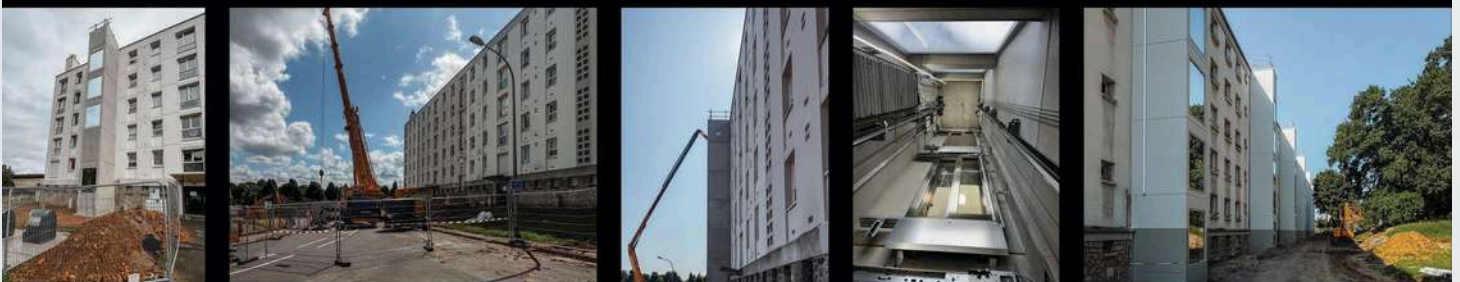
Conception-réalisation : remplacement avec amélioration d'ascenseurs panoramiques, Résidences Fort de Tourneville & Porte des Paons, Le Havre (76) / Maître d'Ouvrage : ALCEANE CHANTIER EN COURS
