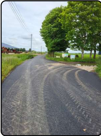
Reprise d'une partie de la rue de Rimbertot en enrobé
