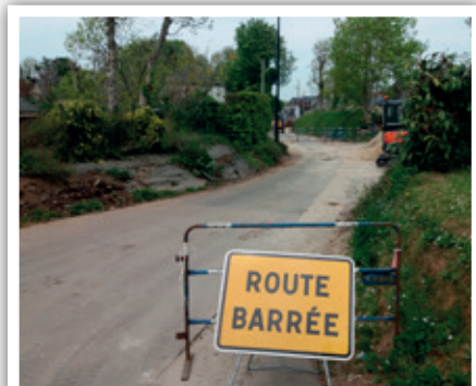
Travaux réseaux eau rue des compagnons
