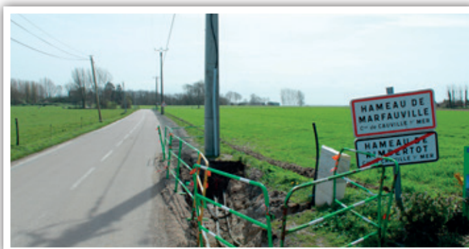
Route de Montivilliers effacement réseau et mise en sécurité des piétons
