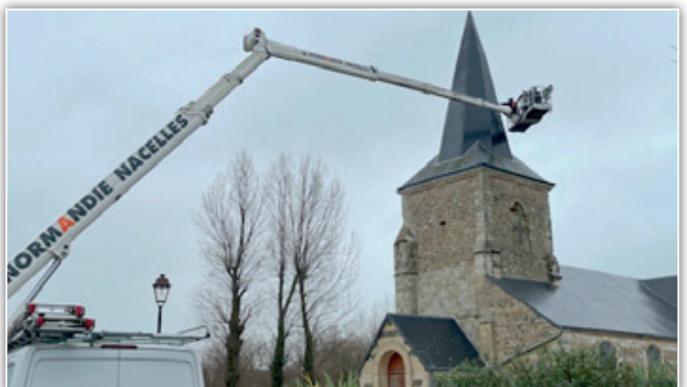
Église Saint Nicolas - Réparation toiture suite tempête
